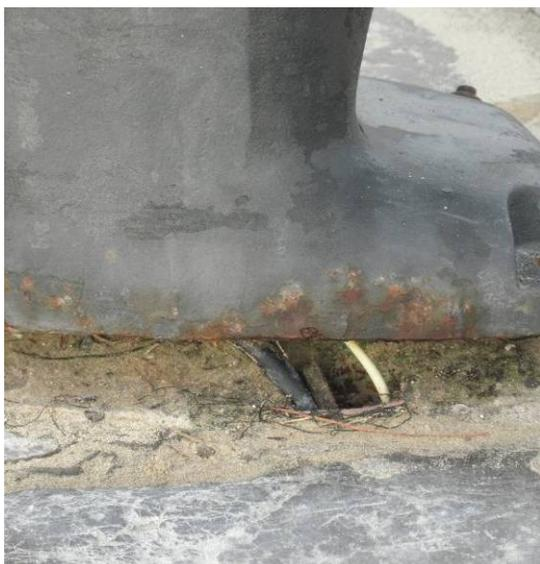
Fotografía 19. Noray con los cables vistos.
