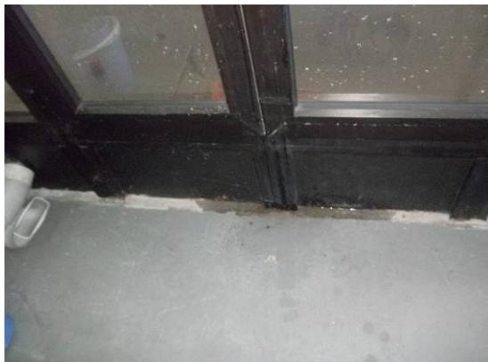
Fotografía 16. Filtración de agua en la ventana.
